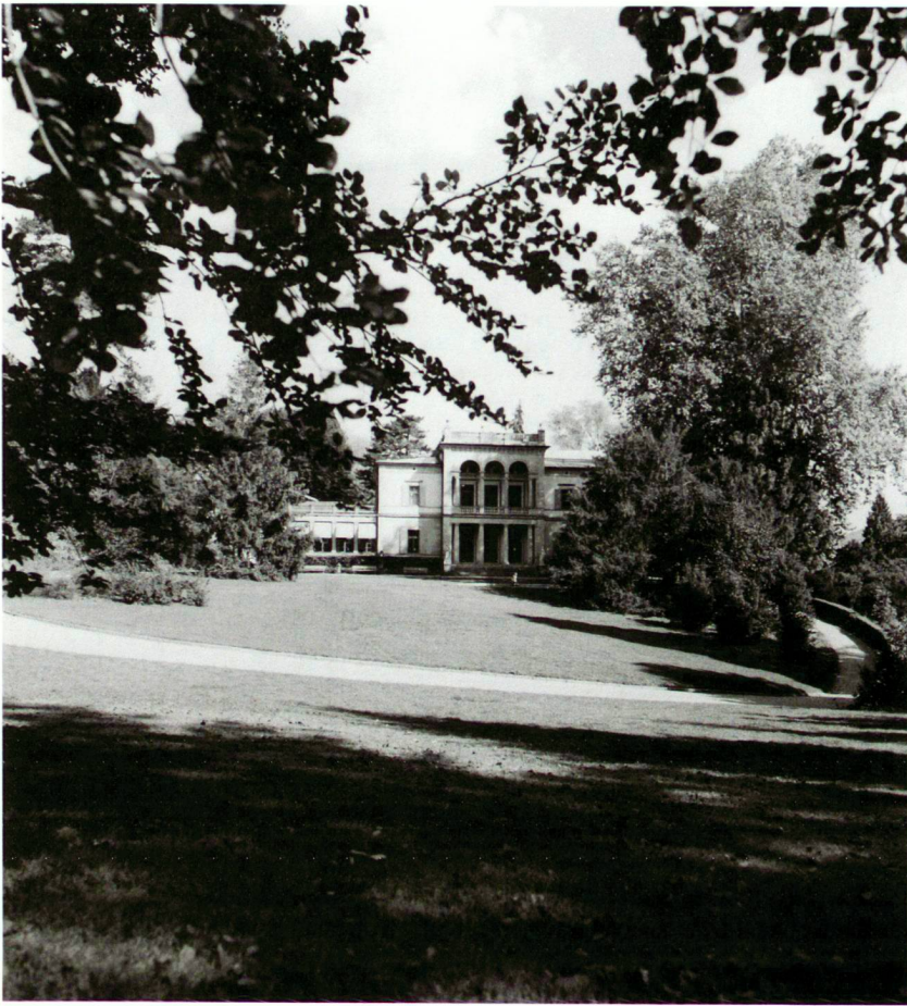
Das Hauptgebäude des Parks, seit Juni 2004 Baustelle der Museums-erweiterung.
