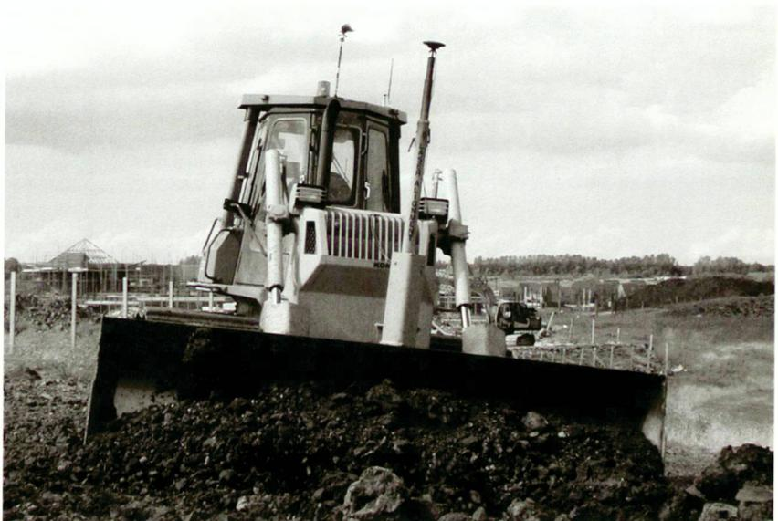
GPS. Dieses Produkt ermöglicht ein GPS-geführtes Planieren gemäss vorgegebenem Oberflächenraster. Die auf dem Display angezeigte Echtzeit-Information beinhaltet: Auf-/Abtragwerte zwischen Ist- und Soll-Position; Querschnitt und Vor-/ Rückblick. Die Dozer-Systeme können in einem grossen Anwendungsbereich eingesetzt werden: Trassendefinition und Absteckung; Böschungsbau; Echtzeit-Auf-/Abtrag; Punkt-Absteckung.
