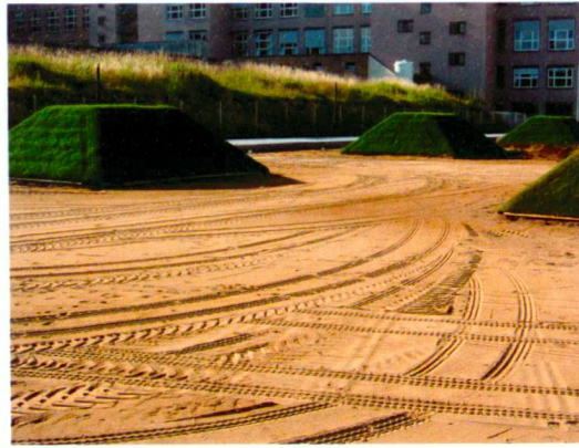
Aufbau der Pyramiden vom Rohbau zur Begrünung.
