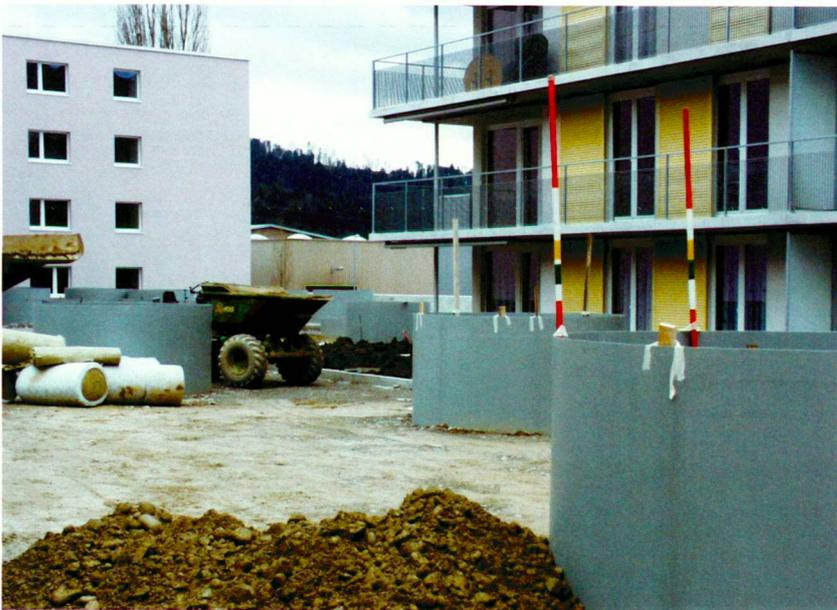
Industriell gefertigte Silo-Röhren aus GfK wurden zur Begrünung von Innenhöfen in Wettingen als Pflanzenbehälter eingesetzt.
