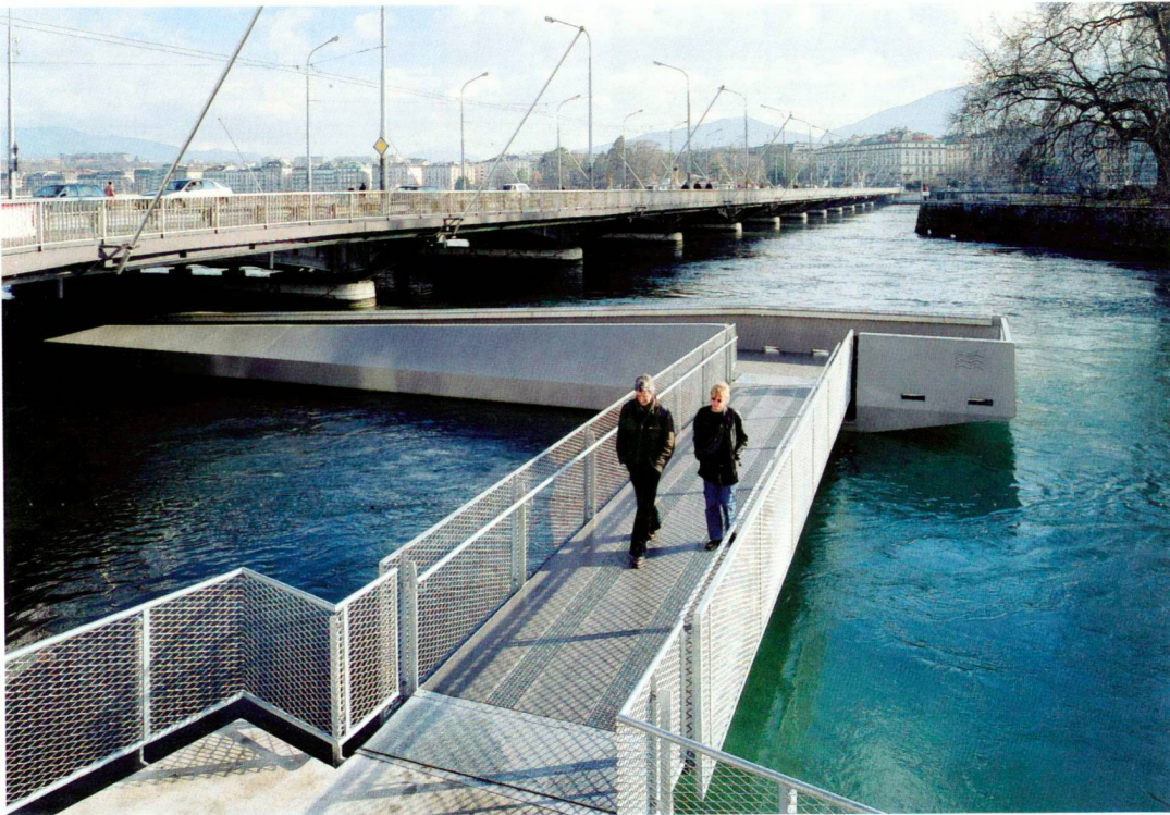
Schwimmende Passage unter dem Pont du Mont- Blanc
