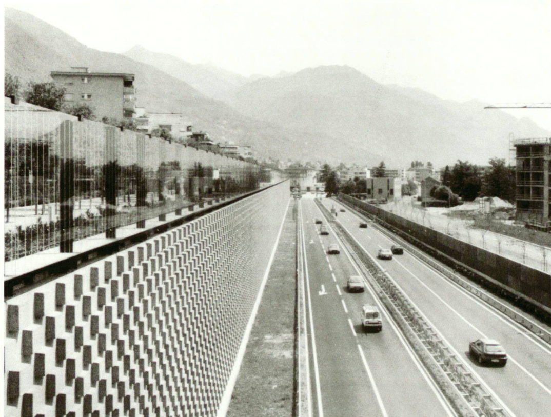
Stützmauer und transparente Lärmschutzwände
