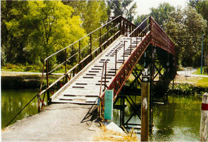
Kleine Stahlbrücke, Architekturtradition der Region.
