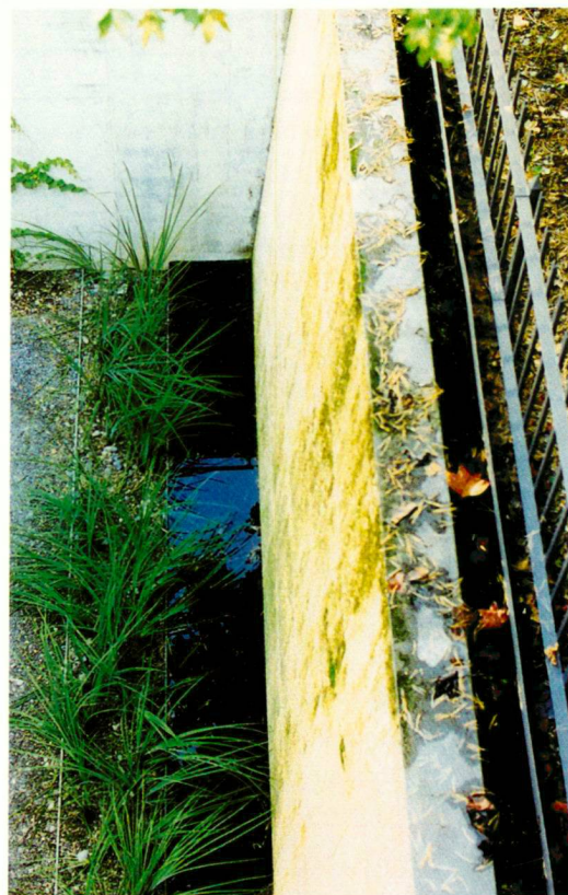
Rinne-Kante-Fläche – das System des Ab- und Überlaufens
