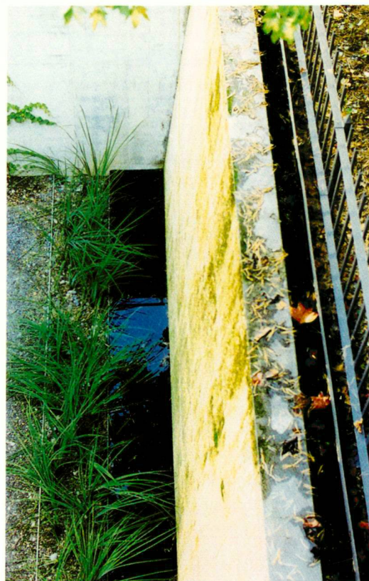
Rinne-Kante-Fläche – das System des Ab- und Überlaufens
