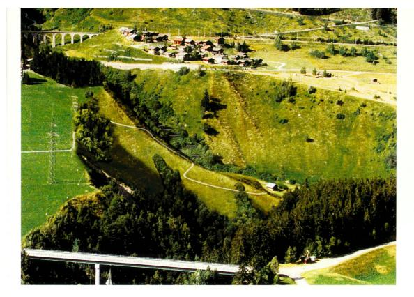
Die Böschungsneigung der Deponie wird wegen der schlechten Qualität des Gesteins flacher als bei den bestehenden Abhängen sein, wobei der Höhenunterschied bis zu neunzig Metern beträgt. Die Flächen können eventuell landwirtschaftlich genutzt werden. Auf der Ablagerungsfläche wird eine neue Ebene entstehen (Flurname vielleicht «Plaun Niev»). Die genaue Ausbildung dieser Fläche kann erst gegen Bauende geplant werden, wenn die abzulagernde Materialmenge bekannt ist.
