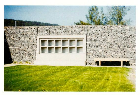
Steinschotterkorb-Mauer mit eingelassenen Urnennischen, ohne Abdeckplatten
