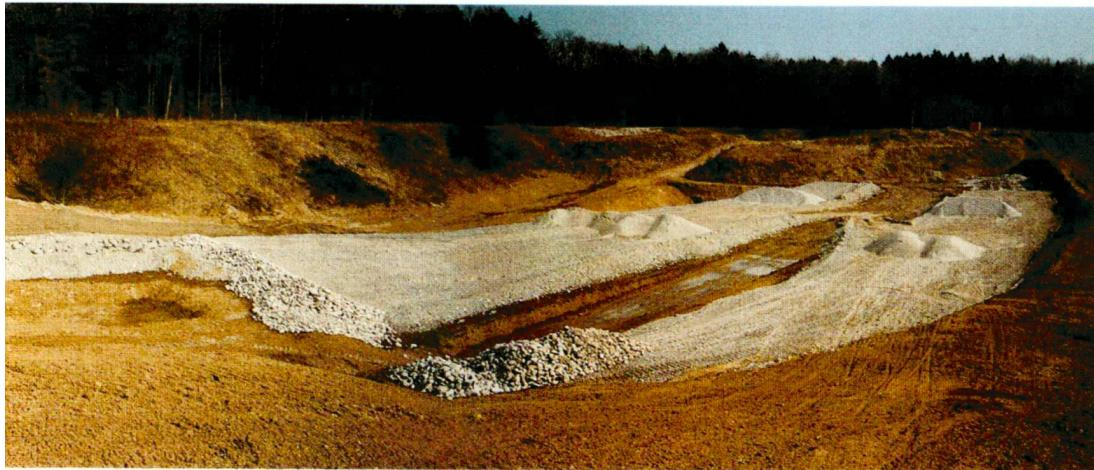
schnell zuwachsende Gewässer mit entsprechenden Maschinen auf rationelle Art vegetationsfrei gehalten werden); Schütten einer etwa achtzig Zentimeter dicken Kiesschicht (Tiefwurzler stossen dadurch nicht in das darunterliegende Auffüllmaterial mit hohem Nährstoffspeicher- vermögen vor).
