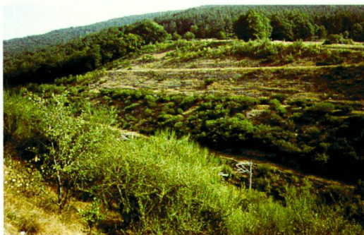
Tranchée près de Scheip- pach: Les pans de roche stables ne sont pas touchés (en haut); quatre ans après la première plantation (à droite).
