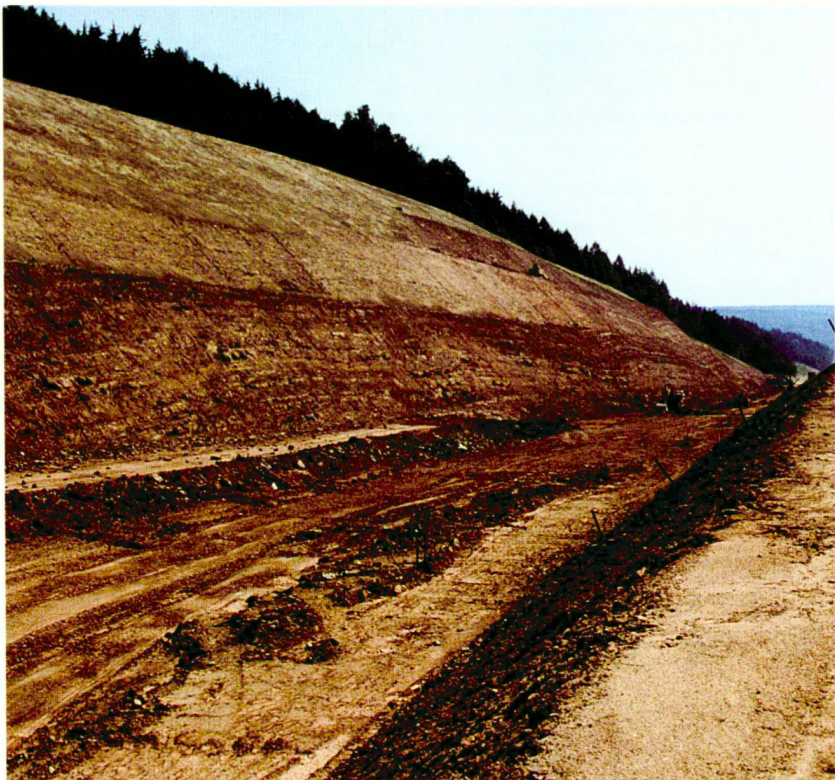
Einschnitt Altengronau: Fels und Lockergestein – vor und nach der Ansaat und Pflanzung.
