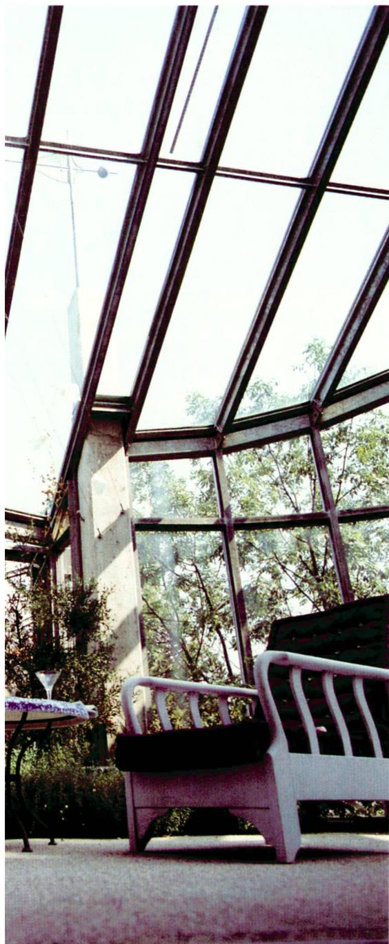
**L'objectif était de concevoir, à Bienne, des immeubles selon les principes de «l'architecture solaire écologique». L'utilisation optimale de l'énergie solaire et l'emploi judicieux de plantes sur les verrières remplacent la climatisation et permettent d'économiser jusqu'à 30 % d'énergie de chauffage.**
