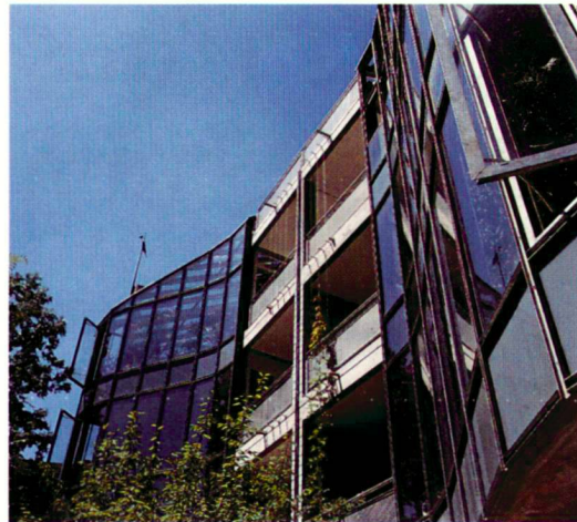
Glashäuser und Balkone auf der Südseite
