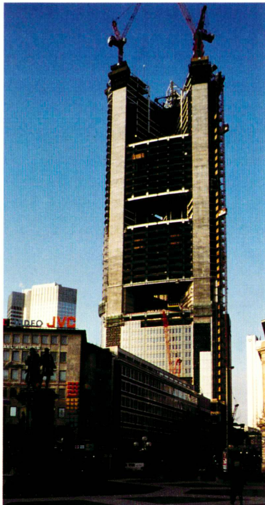
Das wachsende Hochhaus im Rohbau
