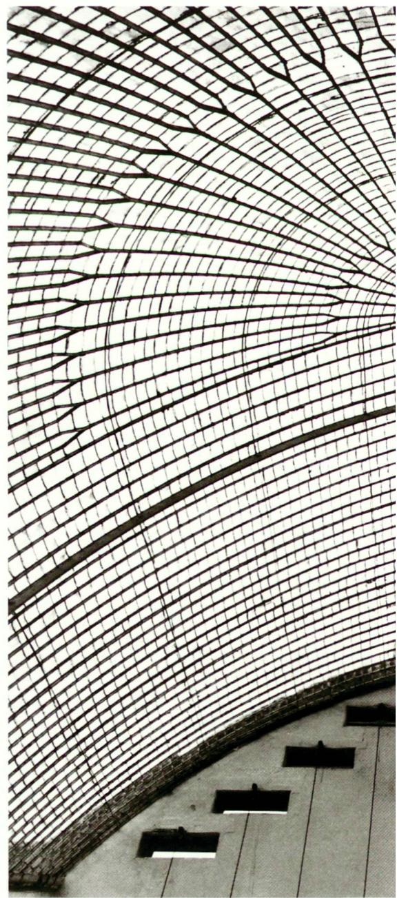
se Konstruktion erst nach Einsetzen der Glasscheiben. Wie auch bei dem noch bestehenden Wintergarten in Loudons Wohnhaus in Bayswater sind hier kleine Glasscheiben schuppenartig verlegt. Diese Art der Verglasung, die sich in späteren Bauten nicht mehr findet, erlaubte es, eine gekrümmte Fläche mit ebenen Glasscheiben zu decken. Größere Scheiben hätten gebogen werden müssen.
