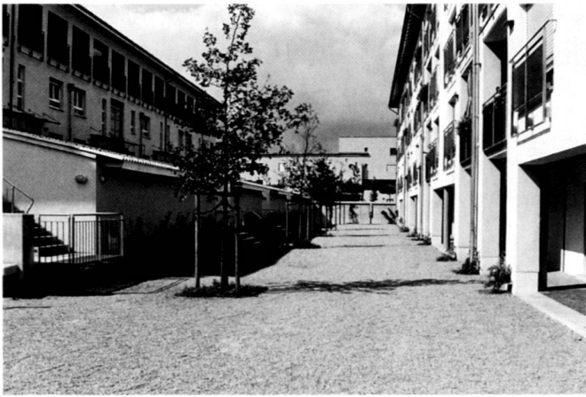
Erschliessungshof. Cour de liaison. Access courtyard.
