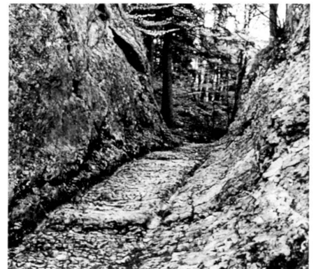
Langenbruck, Oberer Hauenstein (BL). Dieser Hohlweg mit Karrgeleisen wurde schon in römischer Zeit in den Fels gehauen. Foto IVS: Hp. Schneider
