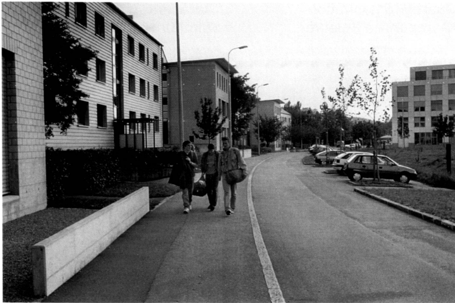
Fassaden zur Hans-Huber-Strasse. Die neuen Kopfbauten sind am Mauerwerk, der alte Aarepark an der horizontalen Stülperschachtelung erkennbar. Fotos: F. Berger, Bern
