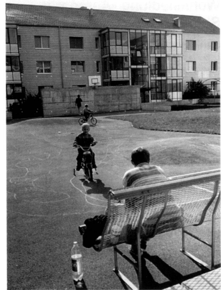
Hof über der neuen Einstellhalle. Bei einigen Häusern wurden die Küchen mit einem Erker erweitert.
