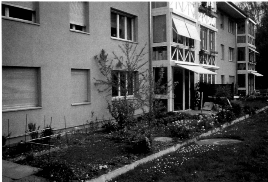
Mietergärten für die Erdgeschosswohnungen. Les jardins des locataires au rez-de-chaussée. Tenants' gardens for ground-floor apartments.
