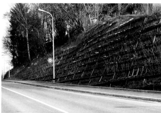
Links: Hangrost als Böschungssicherung.
