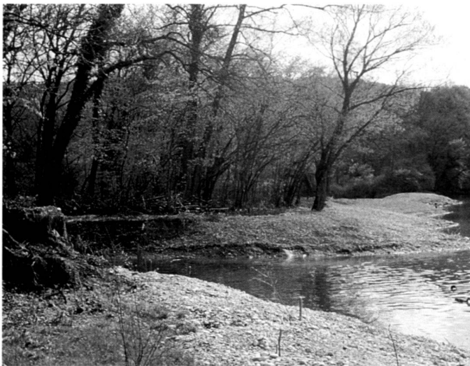
Links: Neu errichtetes Flachufer mit Einführung einer Binnenwasserrinne am Ort der alten Ufermauer, Frühjahr 1992.
