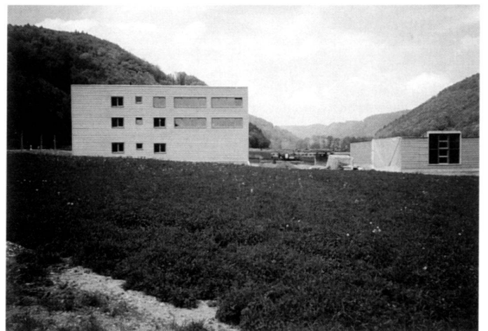
Les échafaudages qui remplacent les arbres fruitiers à la périphérie du village, les bâtiments industriels dans la vallée familière du Wiesental influencent déjà les votations mais pas encore l'action.
