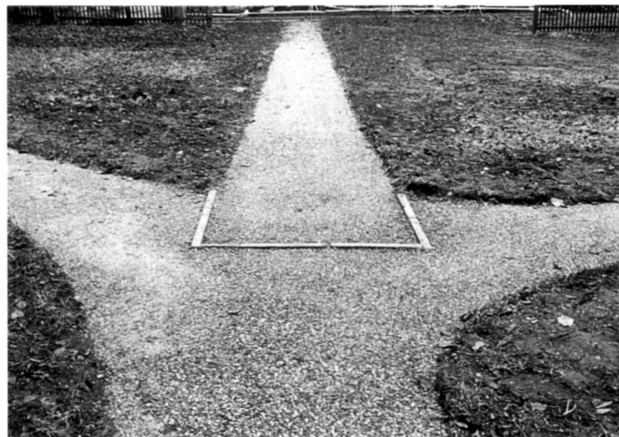
Aufbau der Wege: 15 cm Kofferung, rezyklierter Bauschutt; 4 cm Deckschicht, Strassenkies Spezial von Wimmis.
