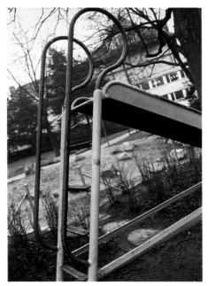
Einfache verschraubte Verbindungen sind jederzeit demontierbar und, wenn nötig, einfach reparierbar.
