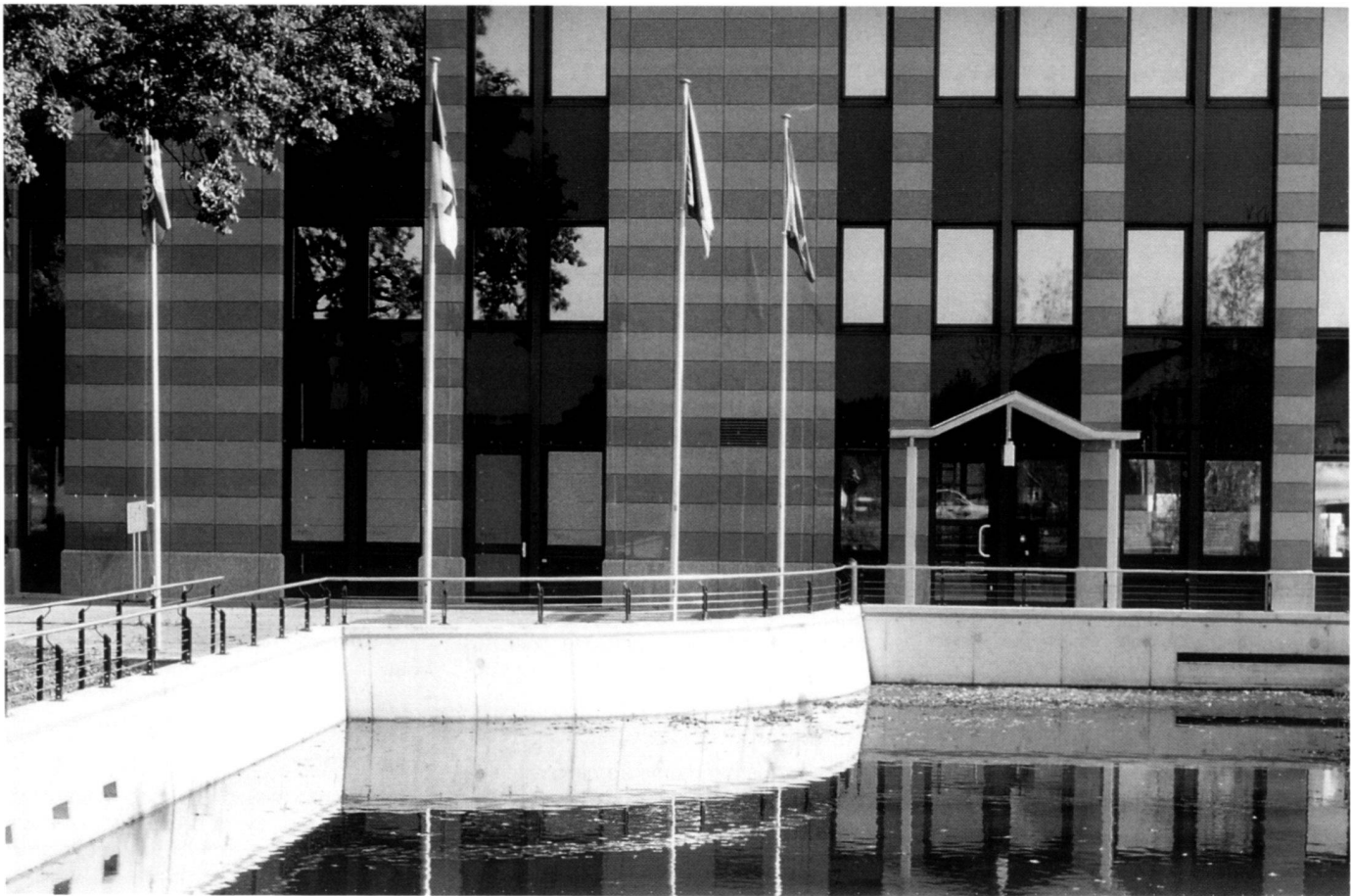
Verwaltungsgebäude des Schweizerischen Bankvereins, Zürich-Opfikon: Grosse Staumauer Teich Haus 1. Am rechten Bildrand Mauer mit Regenwasser-Einlaufbauwerk für das Dach Haus 1 und Auslauföffnung.
