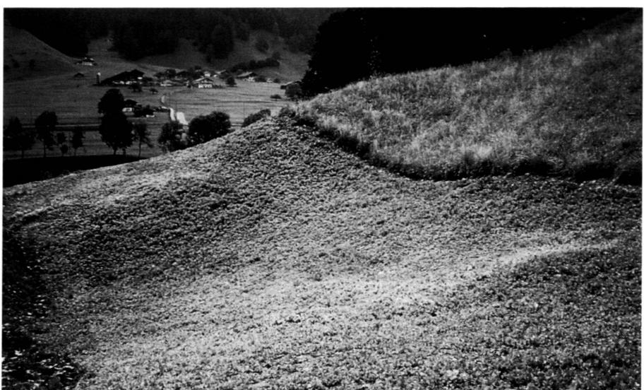
Frutigen, Zwischenbegrünung nach Leitungsverlegung. Der Oberboden wird erst nach der Zwischenbegrünung mit Chinakohl aufgebracht. Die Bodenverbesserungsmassnahmen des Unterbodens nach einem Eingriff sind wichtige Voraussetzungen für eine erfolgreiche Bodenrekultivierung.
