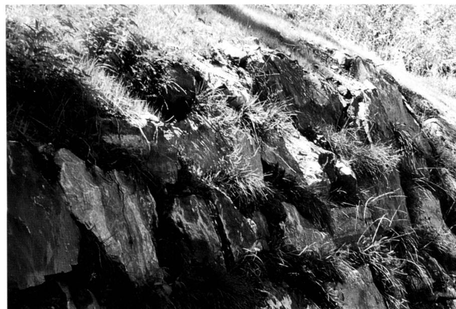
Fensterstollen Mitholz, Böschungssicherung mit einer begrünten Steinblockmauer: Die Materialien stammen aus der Umgebung. Das Bauwerk ist sofort ins Landschaftsbild integriert. Die Grassoden zwischen den Blöcken verhindern die Feinmaterialerosion.
