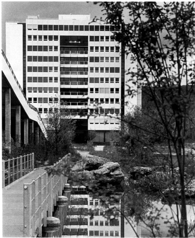
Links: Südweg zur Kantine mit Feuchtbiotop. Verfasser: S. Eigenheer. Rechts: Feuchtbiotop und Ruderalflächen zwischen Industriebauten.
