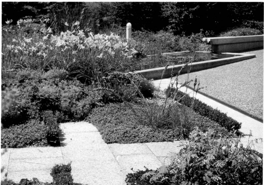
Die Wasserübergabe aus der Rinne in das Wasserpflanzenbecken.
