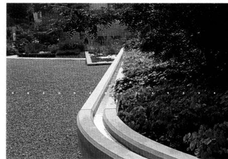
Der Wasserbeckenüberlauf nässt den Sumpfpflanzenteil des Staudengartens und versickert am Ort.
