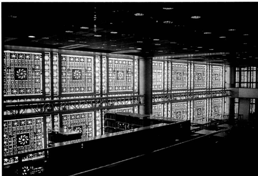
High-Tech-Fassade eines «intelligenten Gebäudes»: «Centre du Monde Arabe» von Jean Nouvel in Paris mit lichtgesteuerten «Blenden».
