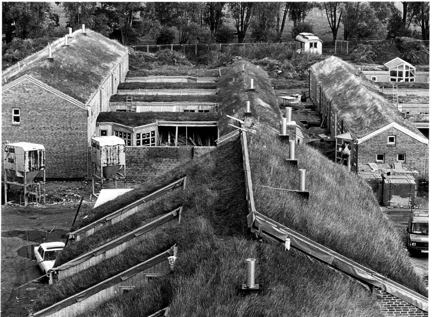
Auch eine Art von «intelligentem Bauen»: Öko-Pioniersiedlung «Laher Wiesen», Hannover 1984/85. Architekten: Boockhoff und Rentrop, Hannover.
