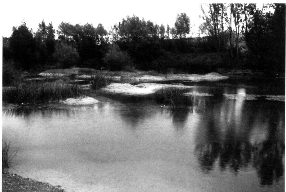
Nach der Absenkung des Wasserspiegels um 1,2 m im vorderen Teil des Baggersees zur Vorhaltung einer grösseren Rückhaltekapazität sind verschiedene Kiesbuckel trockengefallen und grössere Flachwasserbereiche entstanden.
