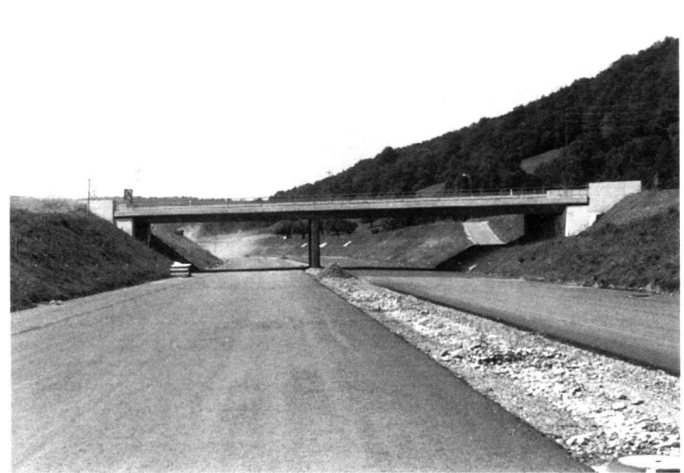
Kantonsstrassenbrücke. Pont sur une route cantonale. Cantonal highway bridge.
