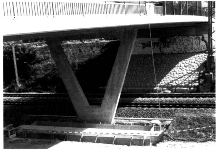
Gestaltete, auf das statisch Notwendige reduzierte Stütze. Détail de la gaine technique. Detail duct.
