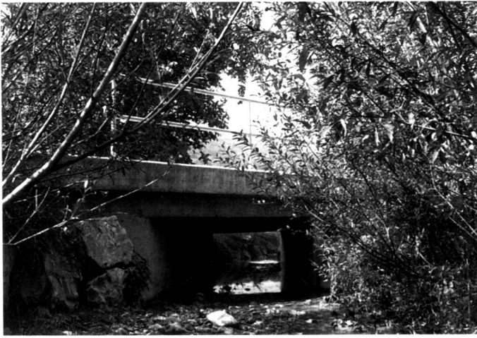
Bachbrücke. Pont sur une rivière. Stream bridge.
