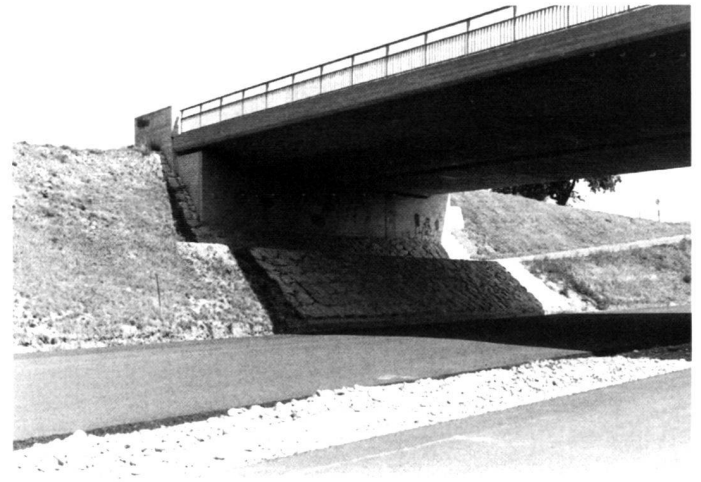
Postament, Widerlager- und Trockenschattenbereich im Detail ausformuliert. Piédestal et aire sèche-ombragée de la butée sont traités en détail. Pier, abutment and dry shaded area shown in detail.
