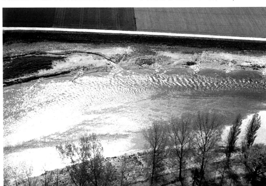
Abb. 7: Etape III. Flussaufweitung mit Buhnen als Ufersicherung. Die Struktur der Wasseroberfläche zeigt das neue, vielfältige Strömungsverhalten.
