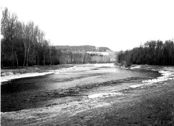
Abb. 5 und 6: Etappe III. Nach einer grosszügigen Profilaufweitung und Vorlandabsenkung entstanden Kiesbänke, die sich immer wieder umlagern (links 1992, rechts 1993).
