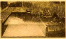
Vor Ort verschweisste Kunststoffbahnen übernehmen, wie bei üblichen Schwimmbecken, die Abdichtung. Die Sarnafil AG, Sarnen, liefert diese Kunststoffdichtung, wenn möglich vorkonfektioniert, auf die Baustelle.
