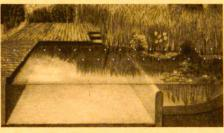
Vor Ort verschweisste Kunststoffbahnen übernehmen, wie bei üblichen Schwimmbecken, die Abdichtung. Die Sarnafil AG, Sarnen, liefert diese Kunststoffdichtung, wenn möglich vorkonfektioniert, auf die Baustelle.
