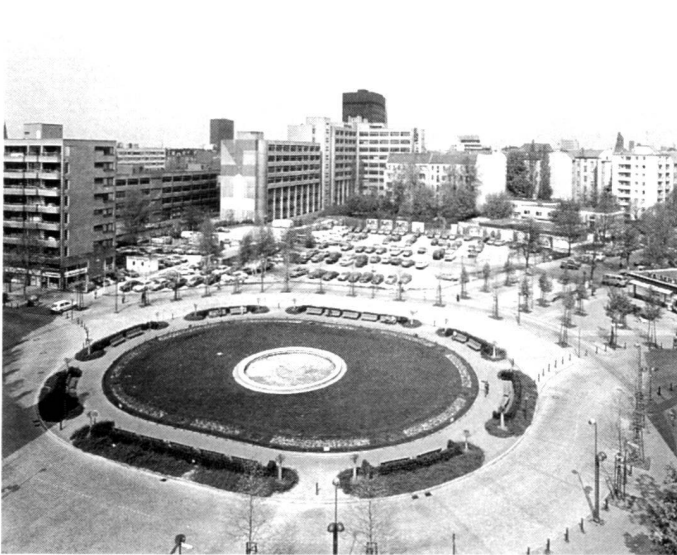
Abb. 2 (links): Prager Platz – 1985 als Schmuckplatz der Kaiserzeit rekonstruiert, die Ringbebauung der Entstehungszeit fehlt jedoch.
