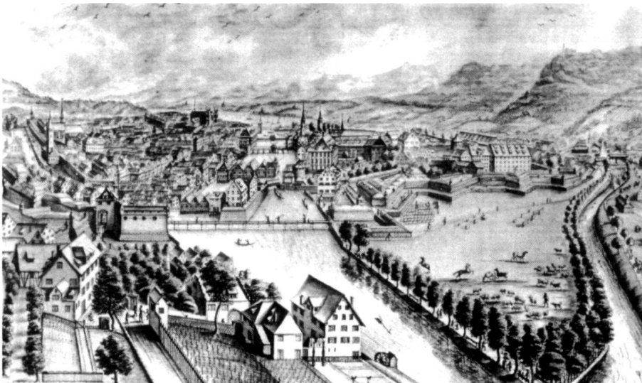
Stadtansicht von Südwesten. Stich von J. Hofmann, 1772. Der Platzspitz hat noch Allmendcharakter, die flussbegleitenden Alleen, ausgestattet mit Ruhebänken, existieren bereits. Im Hintergrund ist die barocke Stadtbefestigung sichtbar. Quelle: BAZ
