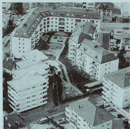
Apollo-Center in Brig. Die Dachgartenfläche zwischen den Bauten ist im Sarnafil-Flachdachsystem mit Sarnavert-Begrünungssystem erstellt.
