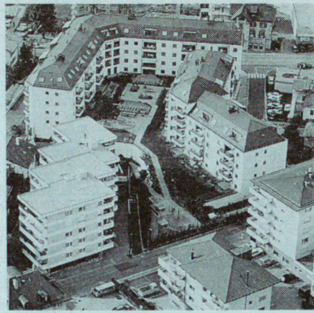
Apollo-Center in Brig. Die Dachgartenfläche zwischen den Bauten ist im Sarnafil-Flachdachsystem mit Sarnavert-Begrünungssystem erstellt.
