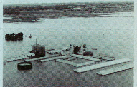
Flutkatastrophe. Schadenerhebung vom Hubschrauber. Foto: ESRI, Redlands, Kalifornien
