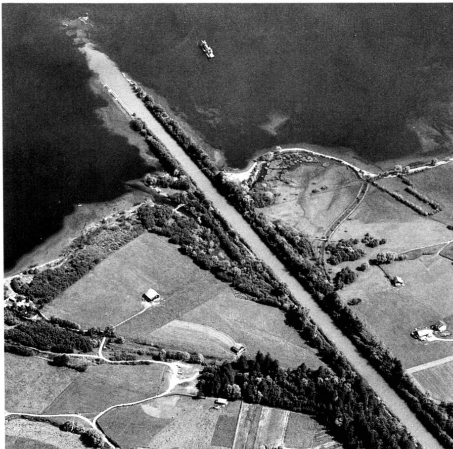
Abb. 1: Kanal­mündung vor der Revitalisierung. Fig. 1: Embouchure du canal avant la revitalisation. Fig. 1: Canal estuary before revitalisation.
