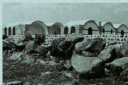
Prix Aga Khan d'Architecture 1992: Système de construction en pierre. Client: Ministère de l'Education, Damas, Syrie. Architectes: Raif Muhanna, Ziad Muhanna et Rafi Muhanna. Les bâtiments ainsi construits coûtent un tiers moins cher comparés aux méthodes traditionnelles de construction. Foto: Kamran Adle
