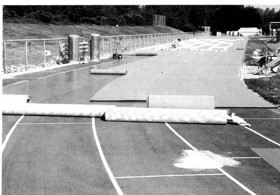
Überdecken eines Altbelages mit Trennmatte und vorfertigem Kautschukbelag. Fotos: Andreas Stüber
