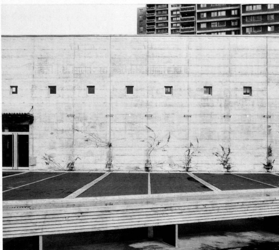
Belagsstreifen strukturieren die Asphaltfläche des Pausenplatzes und dienen gleichzeitig der Oberflächenentwässerung. Der Wassertisch im Vordergrund ist gestalterischer Merkpunkt des Platzes.
