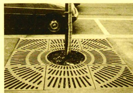
der Baumscheiben an fast jede gegebene Situation. Ausserdem kann die Stamm-aussparung an jedem beliebigen Ort gewählt werden, d.h., es sind Baumscheiben mit zentrischer oder exzentrischer Stammöffnung möglich.
