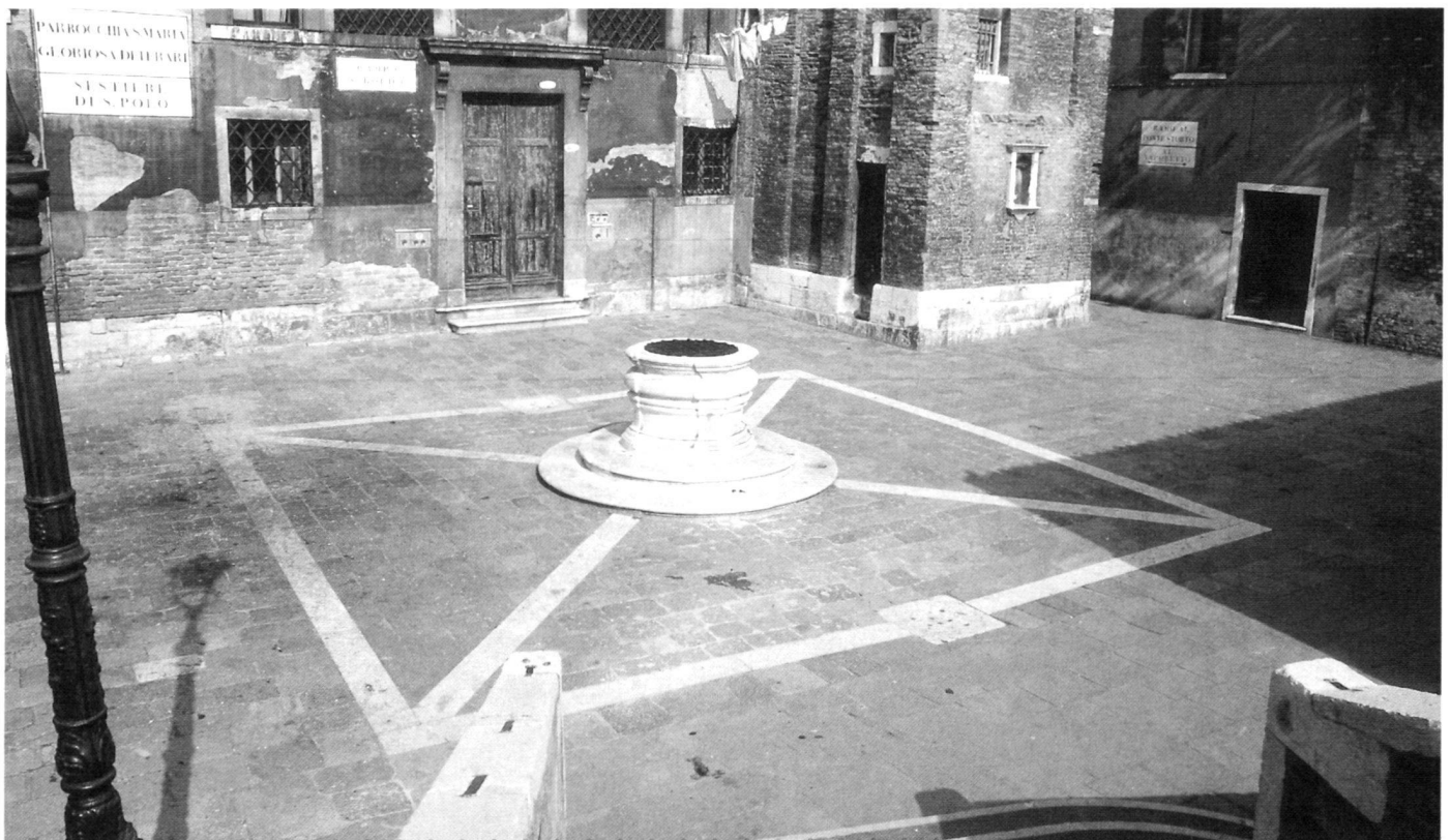
Quartiersplatz mit einer darunterliegenden Zisterne für die Trinkwasserversorgung.
