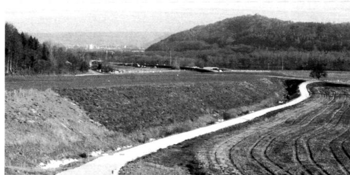
Links: Die stark ausgeprägte Hangkante zeichnet Fahrbahngeometrie und Tunnelkonstruktion nach. Sie zeigt damit die Künstlichkeit der höher liegenden, neu gestalteten Ebene.
