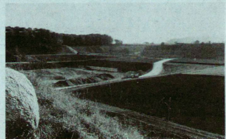
Zielgerichteter Abbau bei der Kieswerk Hauser AG in Mülligen: Hinter der Abbauzone folgt unmittelbar die Wiedergestaltung und Rekultivierung des Geländes.
