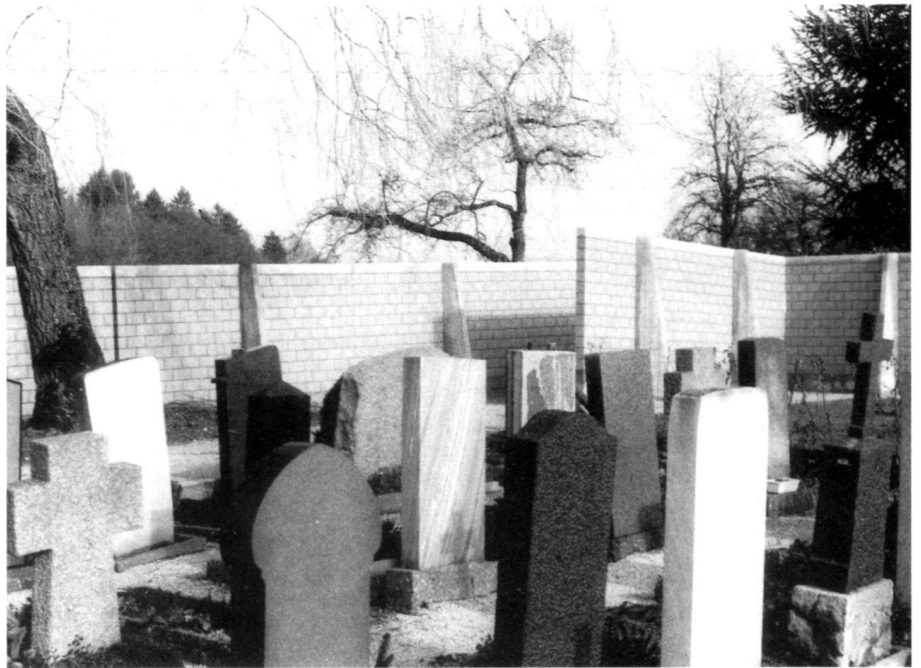
Neue Mauer mit bestehenden Grabsteinen. Foto: G. Vogt, Zürich Nouveau mur avec tombes existantes. New wall with existing gravestones.
