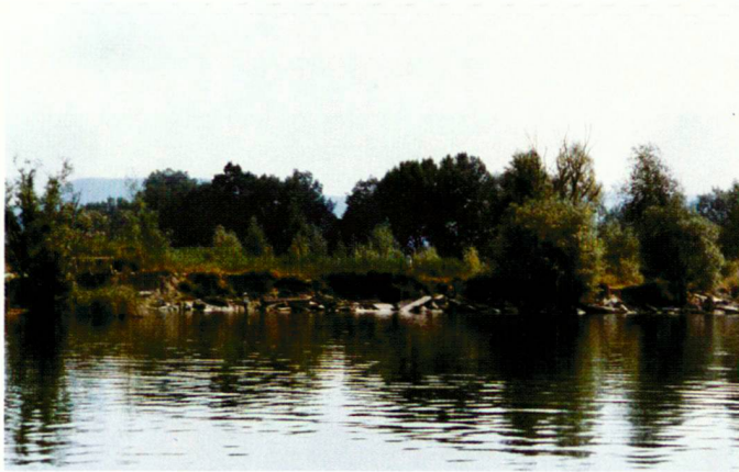
Ufer vor und während der Schüttung.
