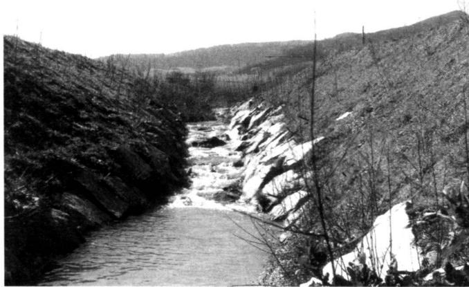
Links: Unterster Bachabschnitt mit steilen, hohen Böschungen. Tiefer Geländeinschnitt zur Überwindung der Niederterrassenkante.
