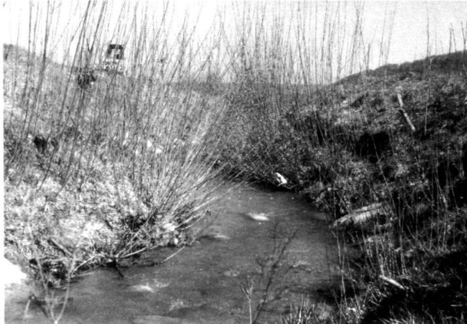
Links: Ufersicherung mit Faschinens-Spreitlagen-Kombinationen (1 Jahr nach Einbau).
