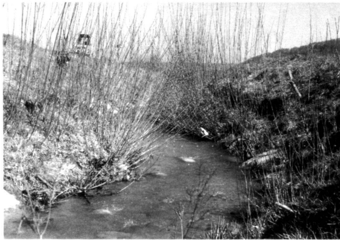
Links: Ufersicherung mit Faschinen-Spreitlagen-Kombinationen (1 Jahr nach Einbau).
